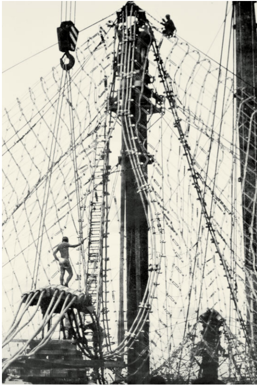
Bild 1 Die Baustelle des Olympiastadions in München
