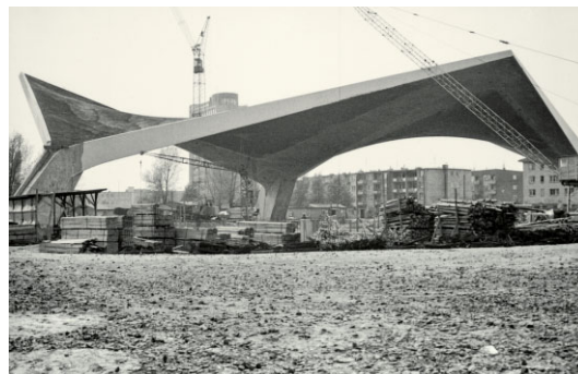
Bild 3 Bau der Alsterschwimmhalle in Hamburg
