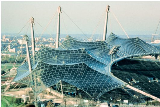
Bild 2 Fertiggestelltes Dach des Olympiastadions
